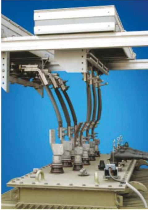
KUVA 8. Kiskojen liittäminen muuntajaan /12/
